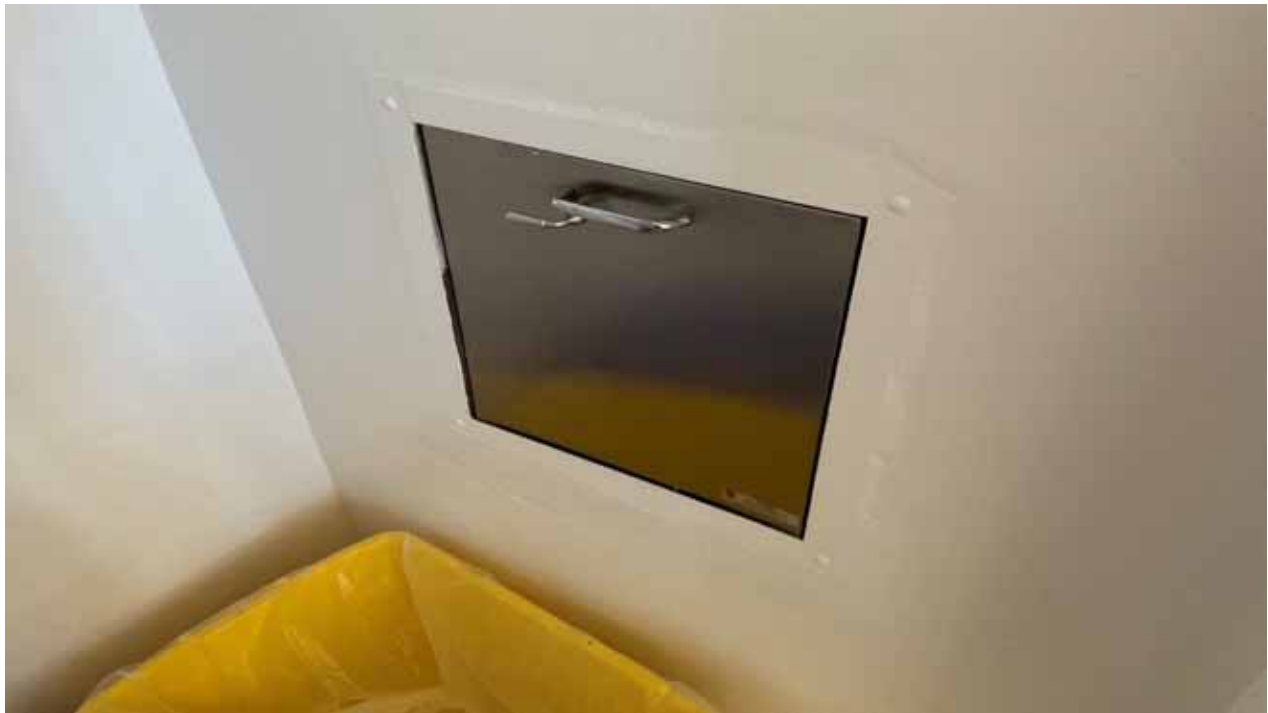
North Bldg Trash Chute Door
