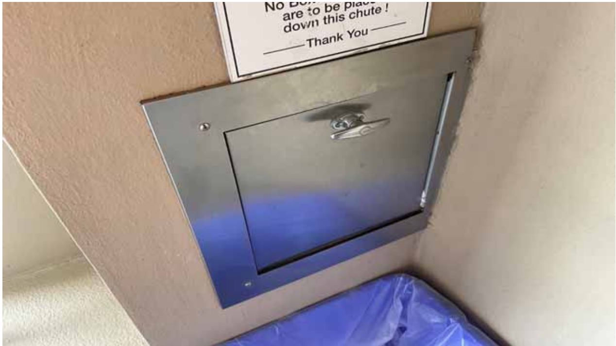
South Bldg Trash Chute Door
